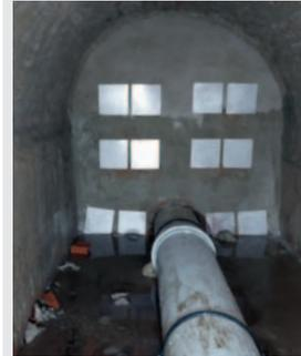
Abmauerung mit Durchleitung DN300
