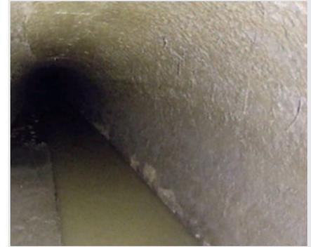
Ist-Zustand des Kanals / Betonkorrosion
